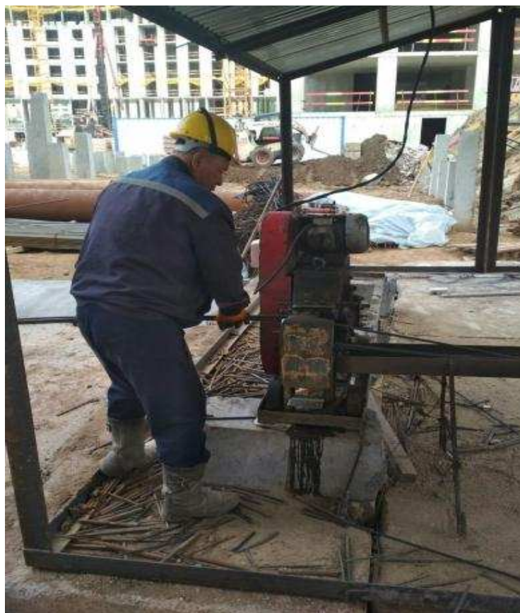
Рисунок 2 – Резка арматуры
