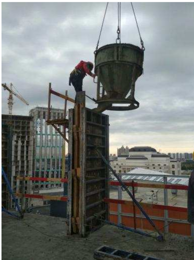
Рисунок 5 - Бетонирование стен
