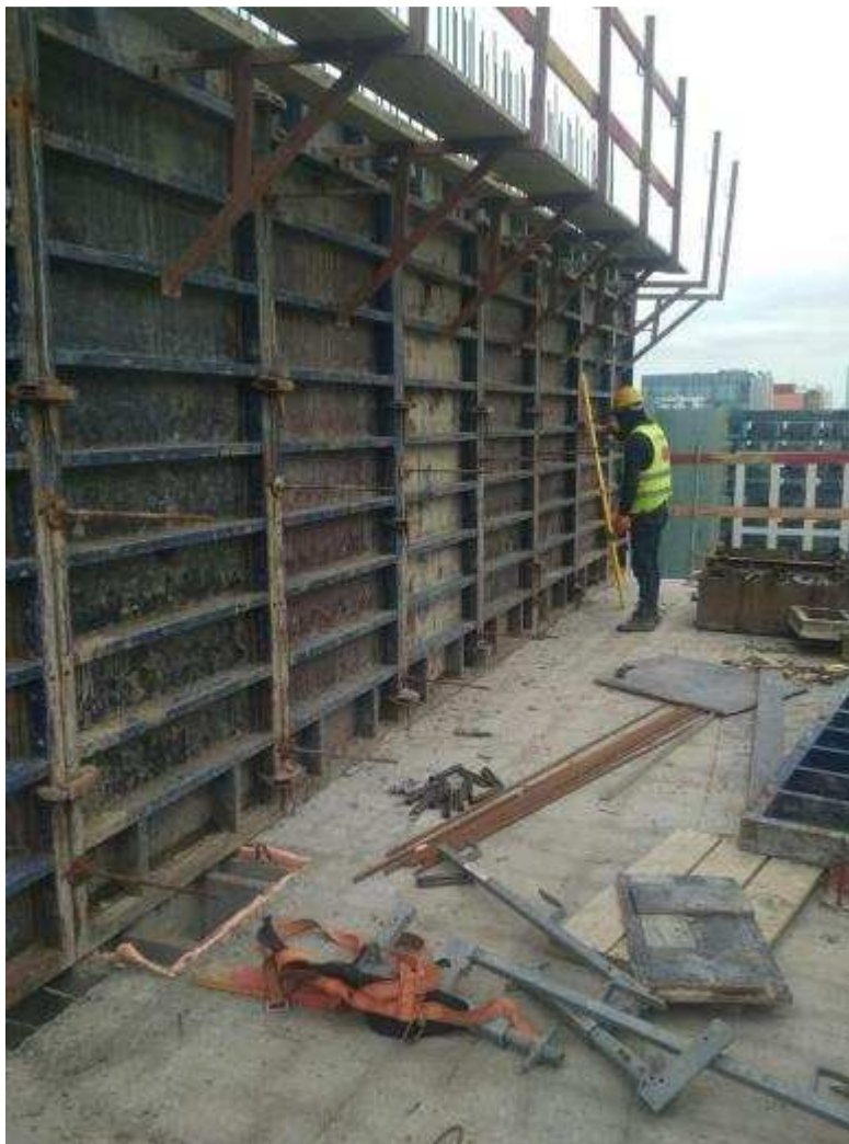
Рисунок 4 – Установка опалубки стен
