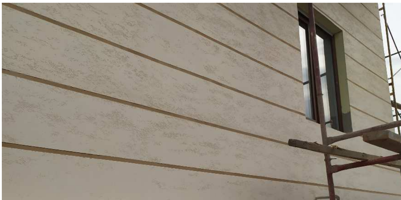
Рисунок 1 - Пример поверхностной структуры декоративной штукатурки фасада под травертин
