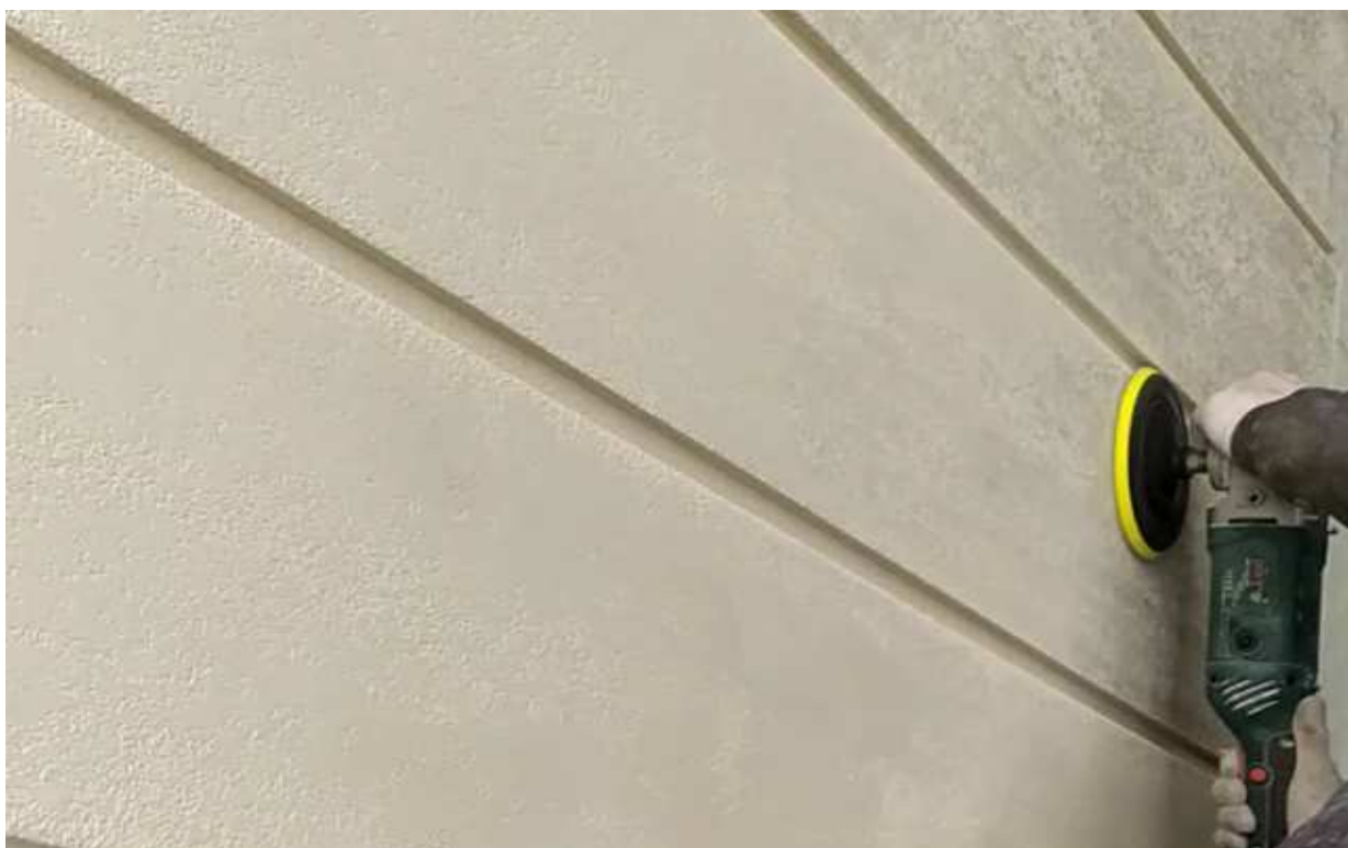
Рисунок 6 – Шлифование декоративной штукатурки
