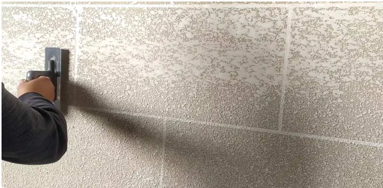
Рисунок 5 – Частичное выравнивание второго слоя декоративной штукатурки
