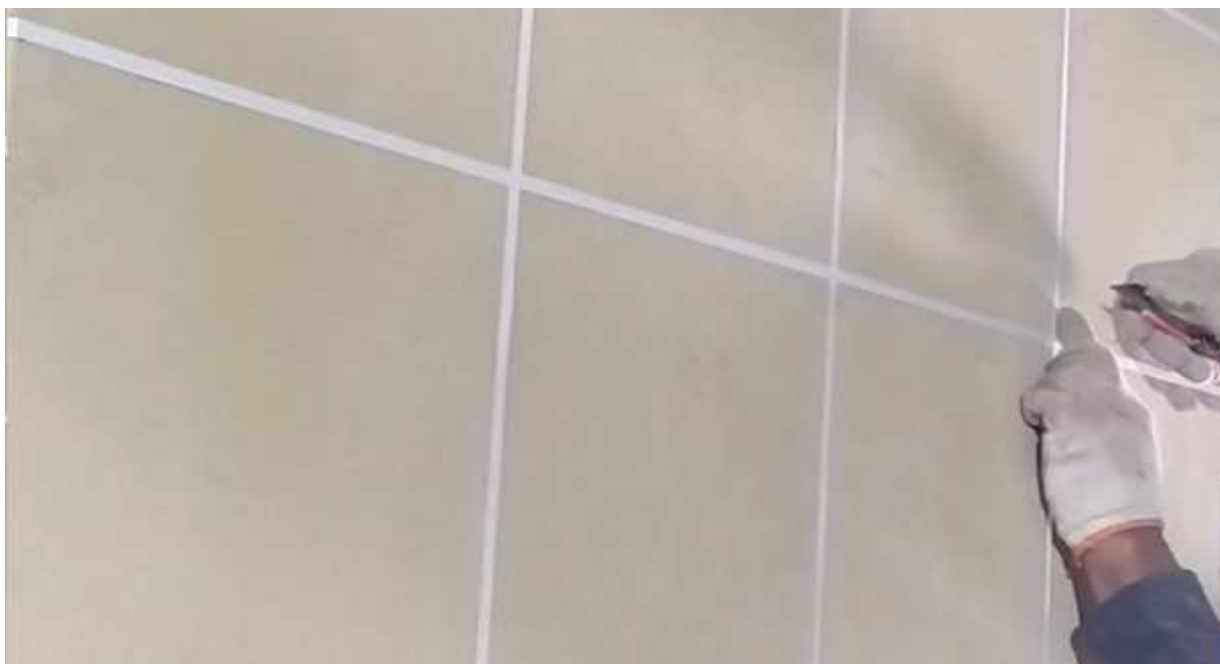
Рисунок 3 - Нанесение разметки
