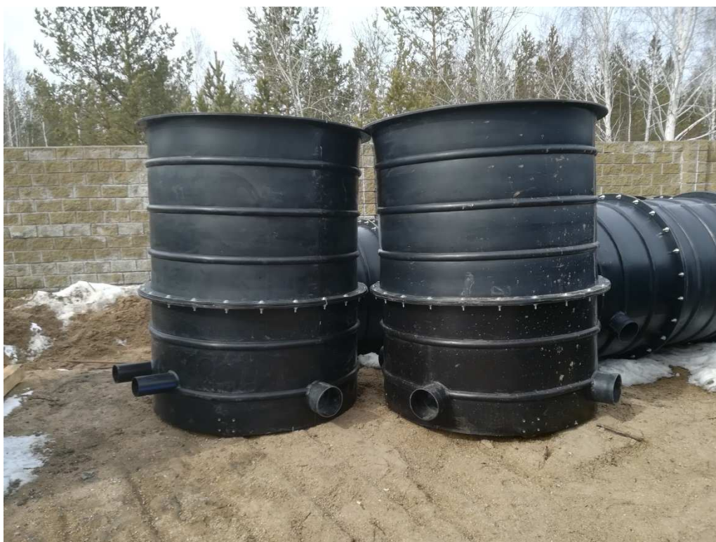
Рисунок 8 – Сборка полимерного колодца.
