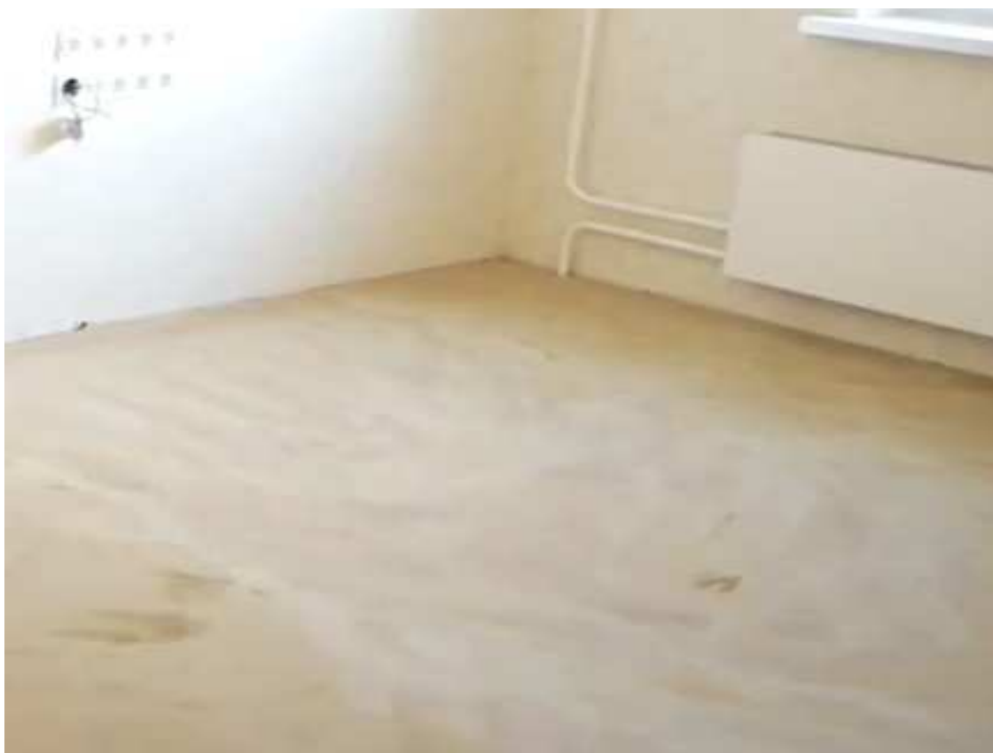
Рисунок 12 - Паркет после нанесения шпатлевки
