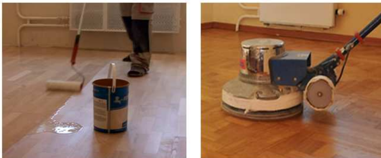
Рисунок 14 – Нанесение лака на паркетный пол валиком и шлифовка плоскошлифовальной машинкой
