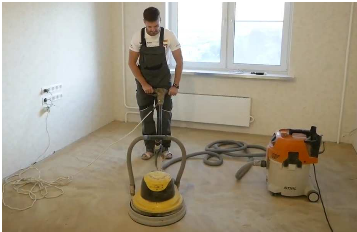
Рисунок 13 – Окончательная шлифовка паркета после шпатлевания плоскошлифовальной машиной
