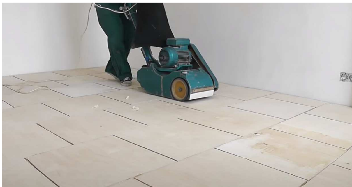
Рисунок 7—Шлифование уложенного основания из фанеры
