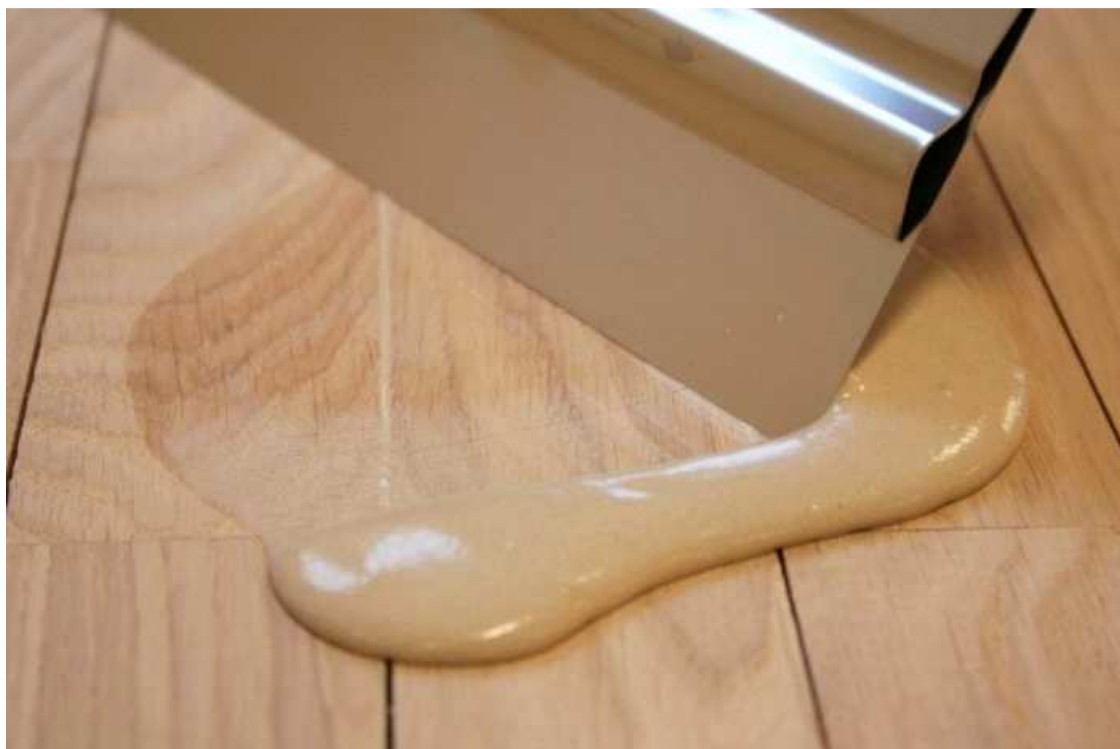
Рисунок 11 - Нанесение шпатлевки на паркетный пол
