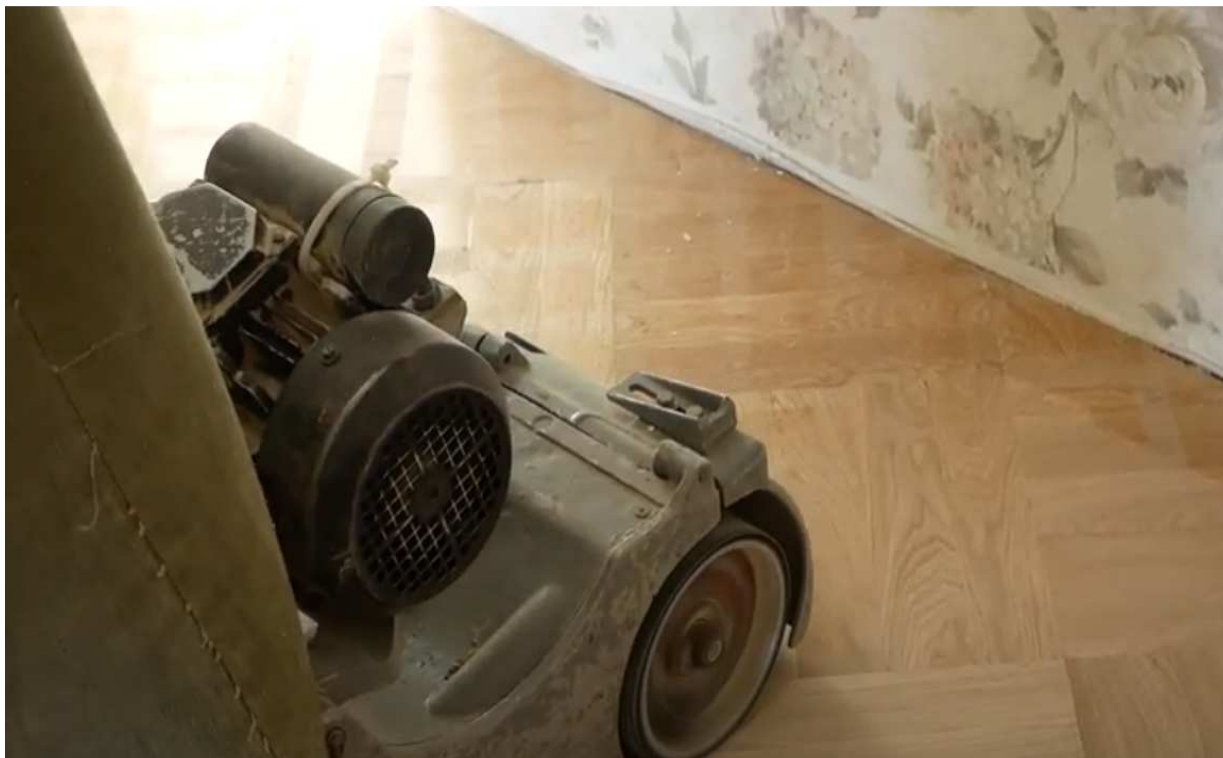
Рисунок 10 – Шлифовка паркета паркетшлифовальной машиной барабанного типа
