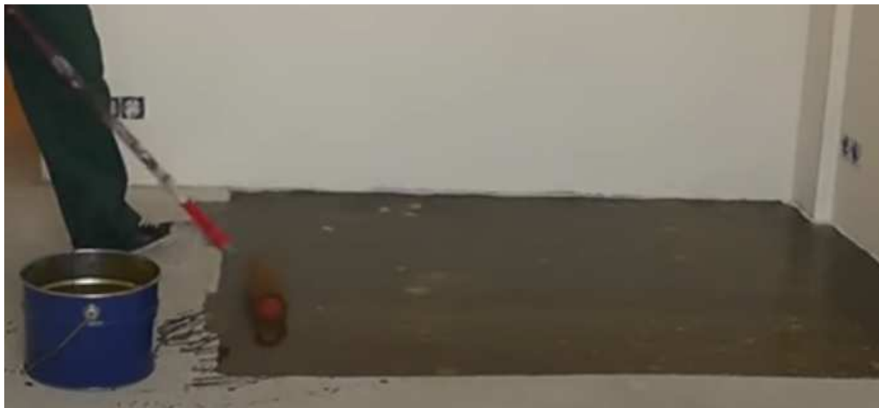
Рисунок 5 - Грунтование бетонной поверхности
