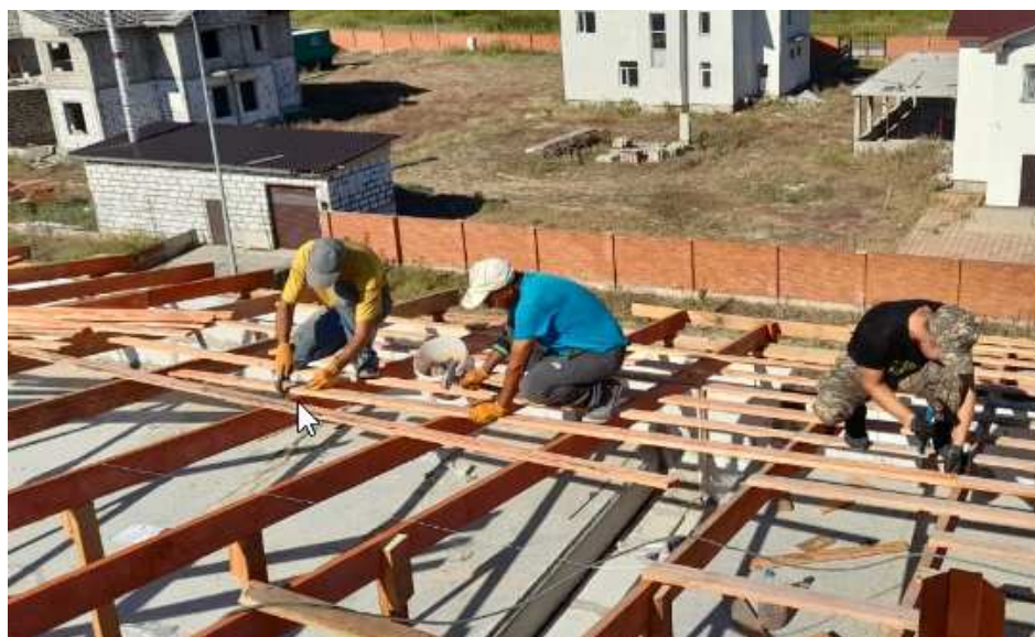
Рисунок 8 – Устройство обрешетки
