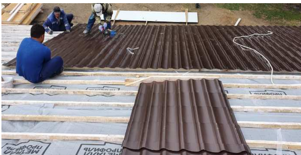
Рисунок 9 – Укладка металлочерепицы
