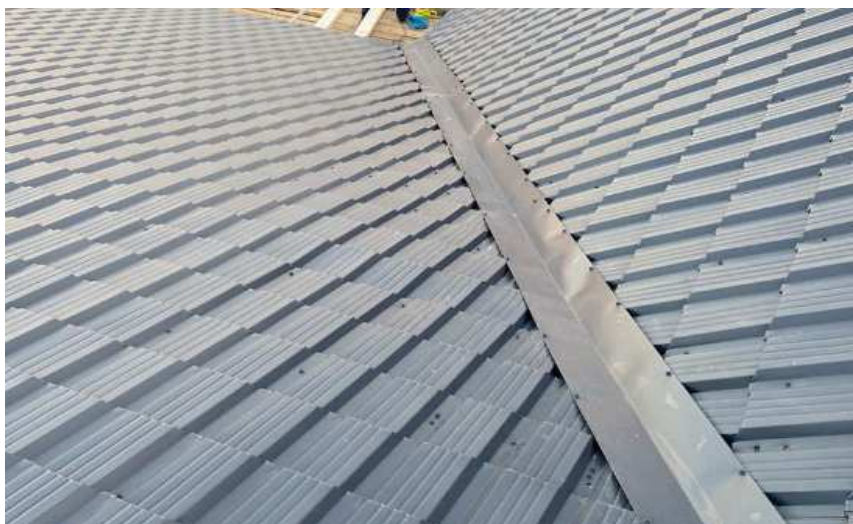
Рисунок 10 – Устройство ендовы кровли
