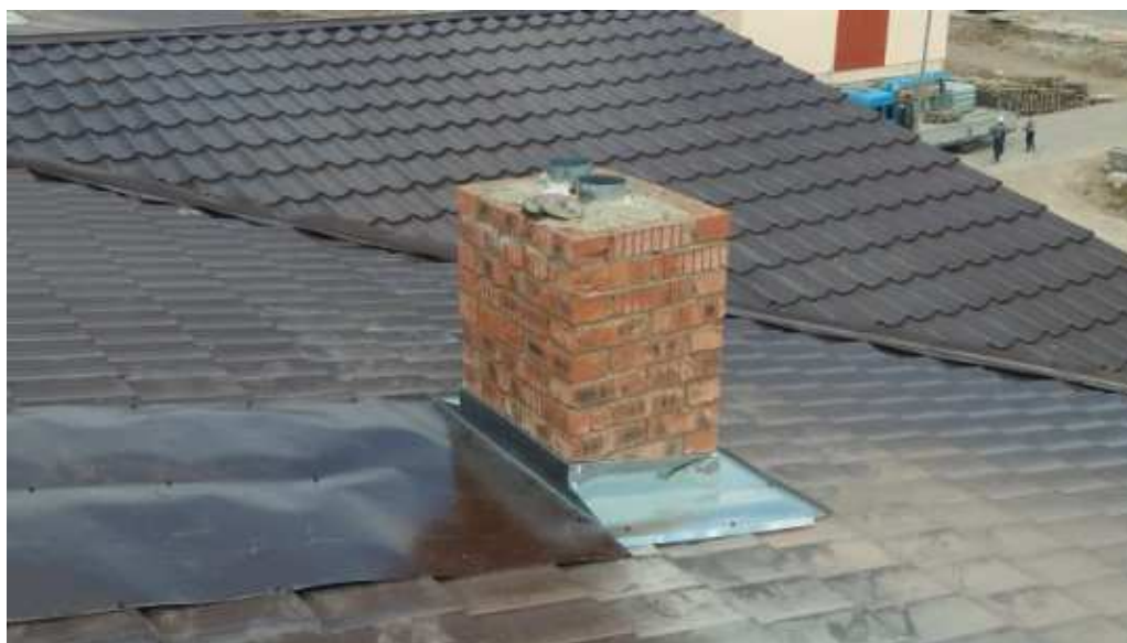
Рисунок 11 - Устройства примыкания к стене (парапету)
