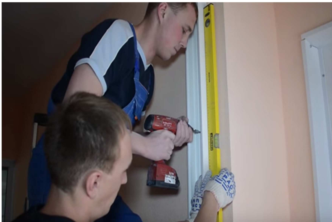
Рисунок 6 - Вертикальная установка короба кабель-канала
