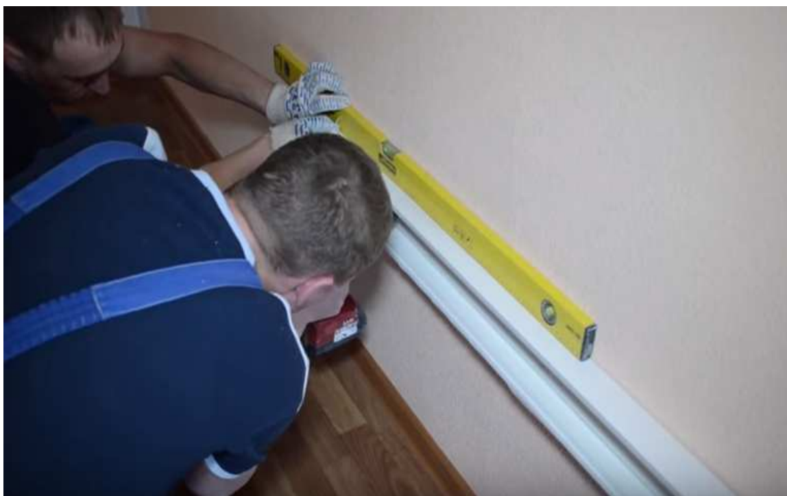
Рисунок 7 - Горизонтальная установка короба кабель-канала
