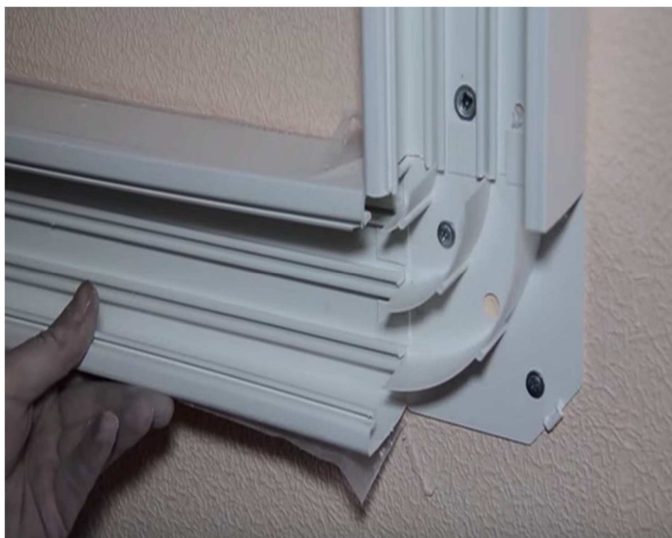
Рисунок 5 - Крепление кабель-канала
