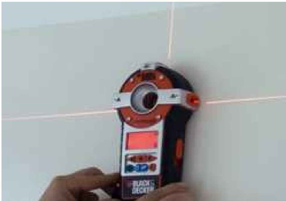
Рисунок 4 - Разметка трассы с применением лазерного уровня
