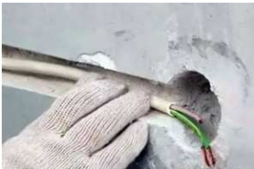
Рисунок 10 - Общий вид штрабы в стене
