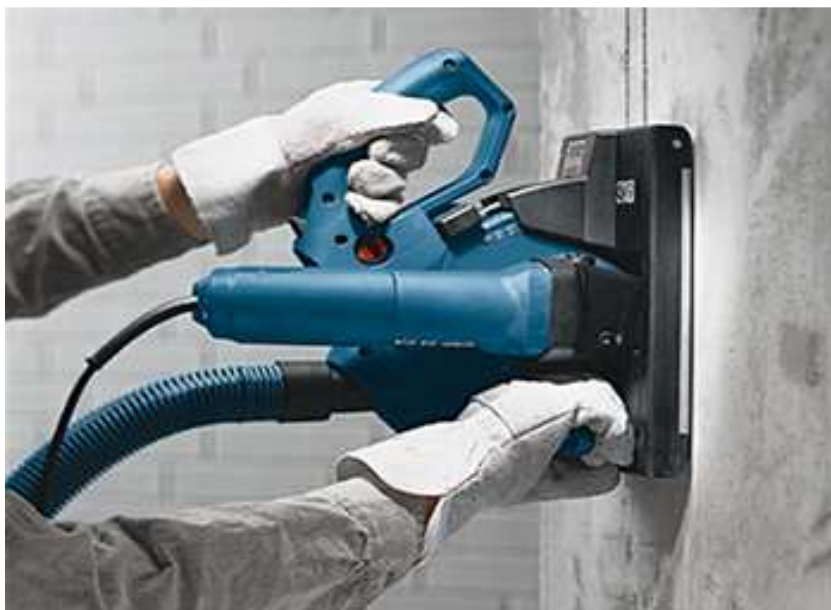
Рисунок 9 – Устройство штрабы с применением штробореза
