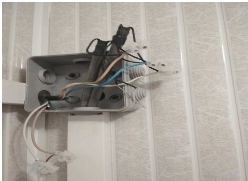
Рисунок 10 – Монтаж и установка с соединительных термоусадочных муфт
