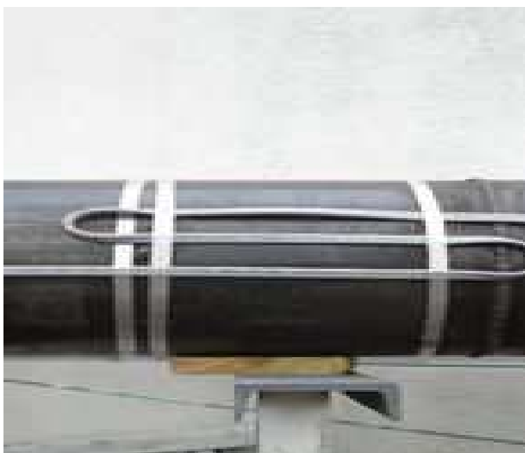
Рисунок 9 – Прокладка греющего кабеля на опоре
