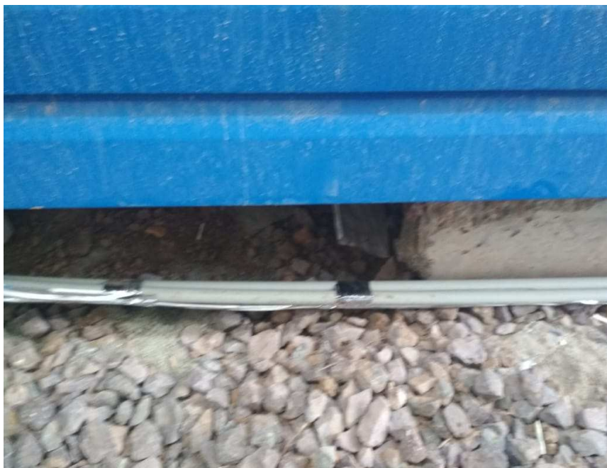
Рисунок 6 – Прокладка греющего кабеля вдоль на пластиковой трубе (а, б)
