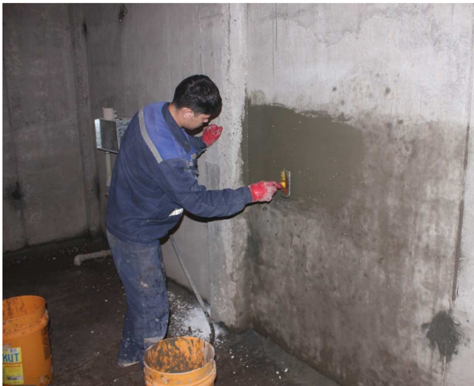
Рисунок 3 – Нанесение гидроизоляционного состава кистью
