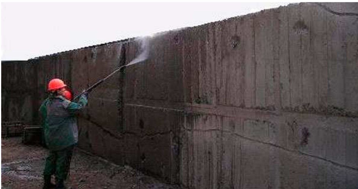
Рисунок 2 – Очистка и смачивание поверхности водой с помощью аппарата высокого давления типа «Karcher»
