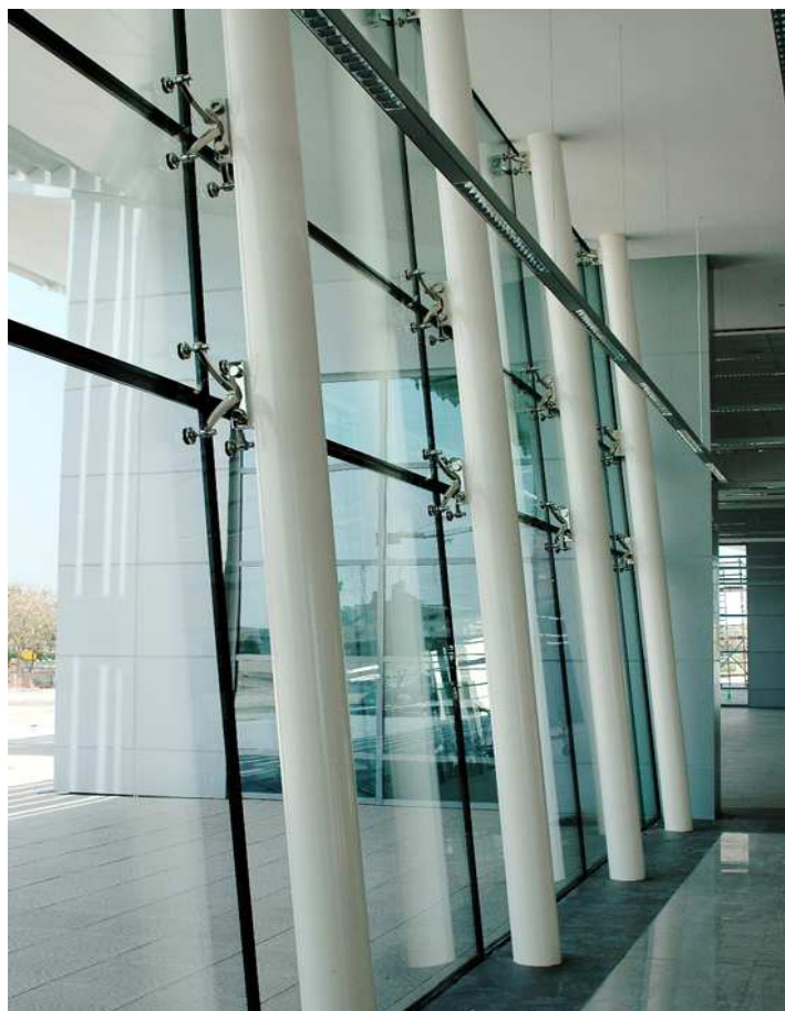
Рисунок 8 - Спайдерное остекление по трубной системе.
