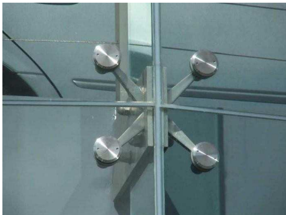
Рисунок 10 – Герметизация стыков в спайдерном остеклении
