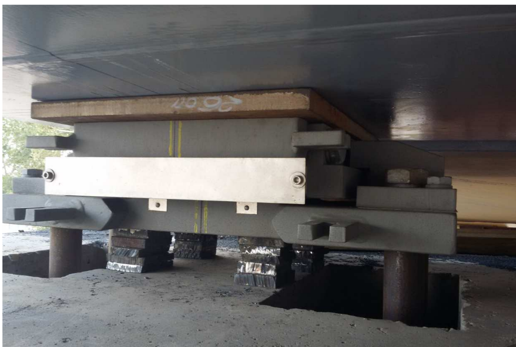
Рисунок 4 – Общий вид смонтированной опорной части без бетонирования
