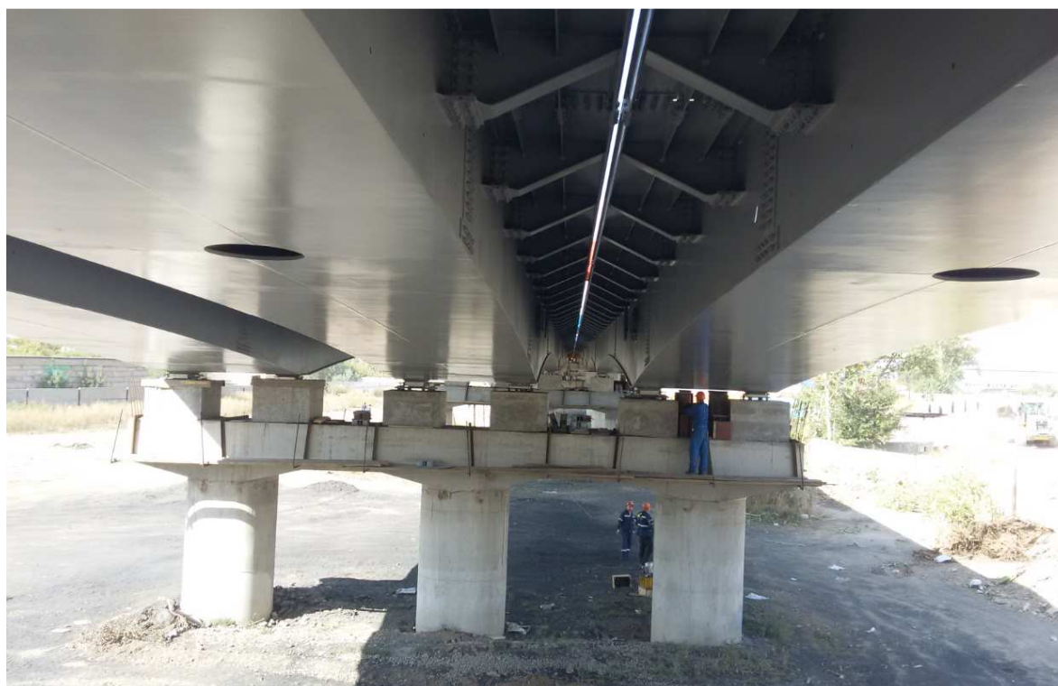
Рисунок 6 – Смонтированные опорные части на подферменниках
