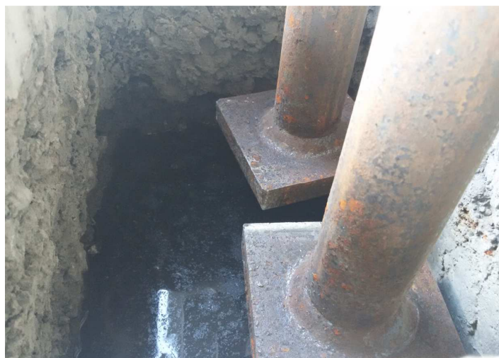
Рисунок 3 – Общий вид анкеров опорных частей в анкерных колодцах
