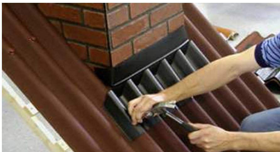
Рисунок 22 – Установка покрывающего фартука
