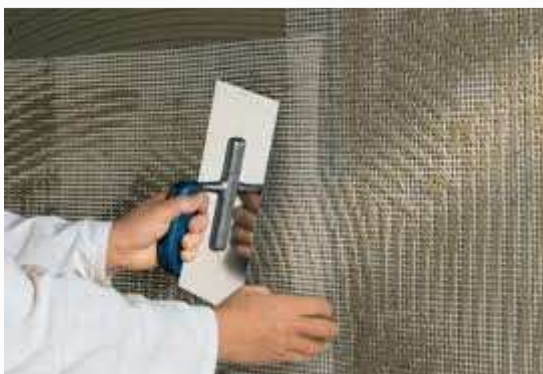
Рисунок 4а - Нанесение клеевого раствора на поверхность стены
