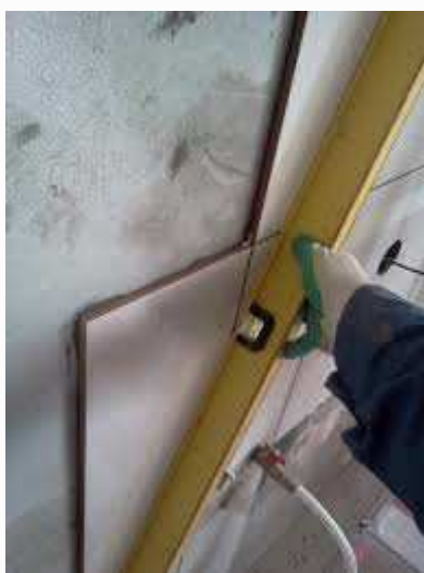
Рисунок 8.Проверка уровня укладки плиток
