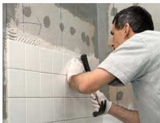
Рисунок 6. Осаживание плитки
