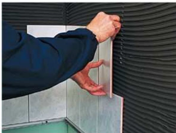
Рисунок 5. Прижим плитки к облицовываемой поверхности
