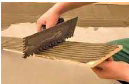
Рисунок 4б. Нанесение клеевого раствора для осаживания плитки
