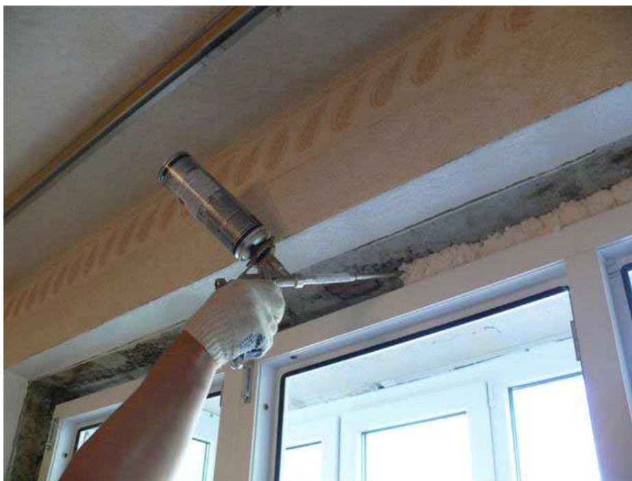
Рисунок 2 – Заполнение швов между оконным блоком и проемом
