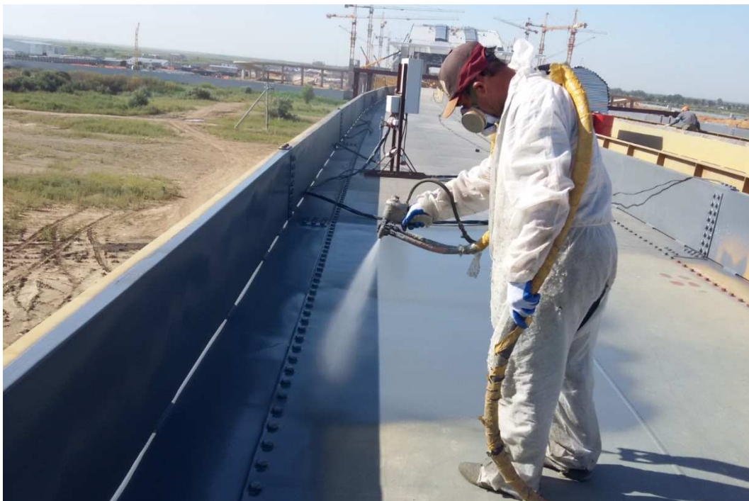
Рисунок 15 – Процесс нанесения гидроизоляции
