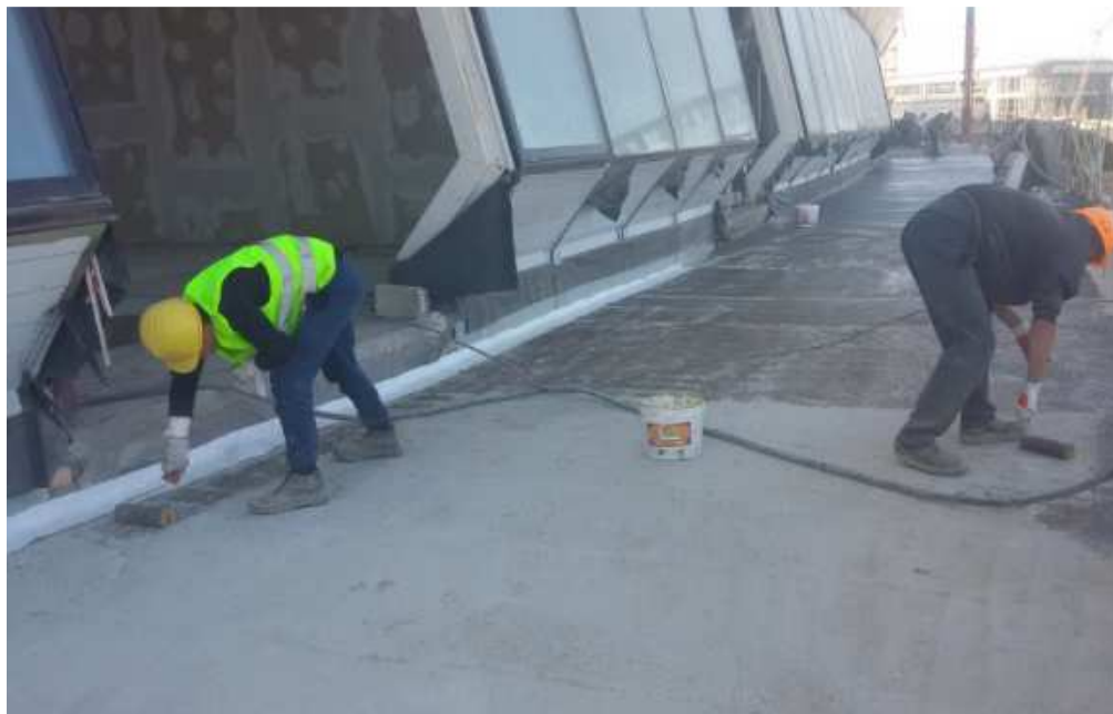
Рисунок 9 - Грунтование поверхности перед гидроизоляцией
