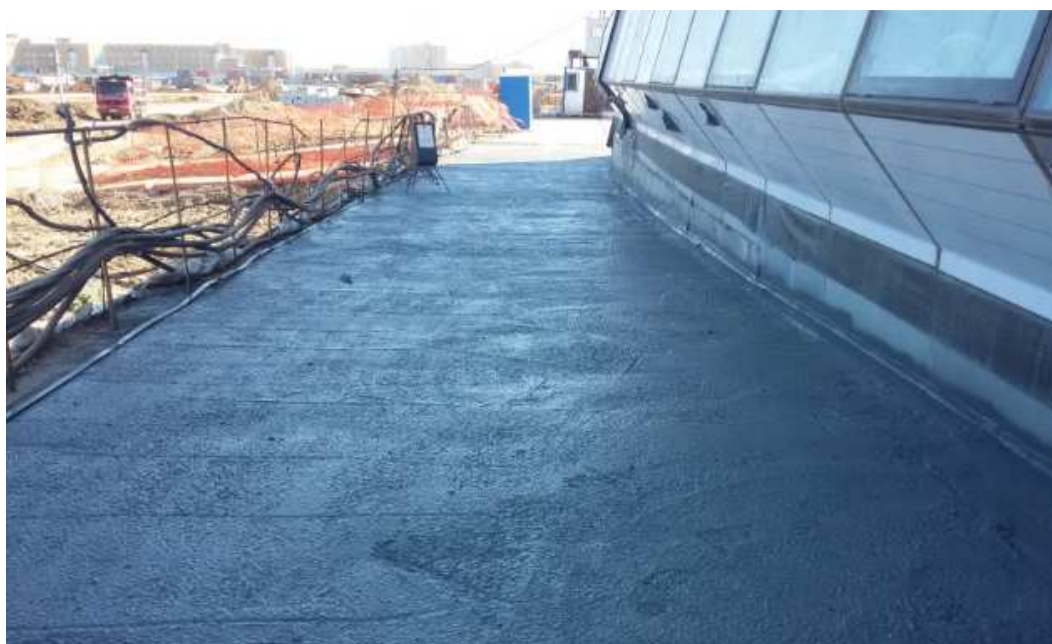
Рисунок 12 - Общий вид нанесенной гидроизоляции на бетонное основание
