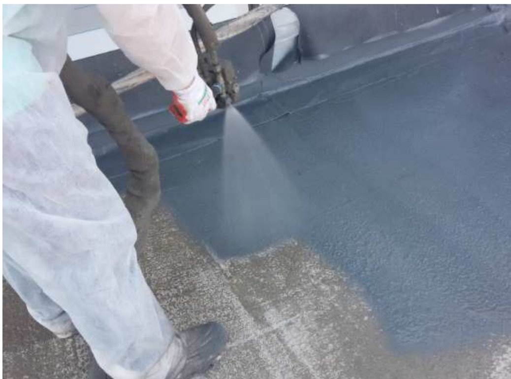
Рисунок 11 - Нанесение полимочевины на грунтованную бетонную поверхность
