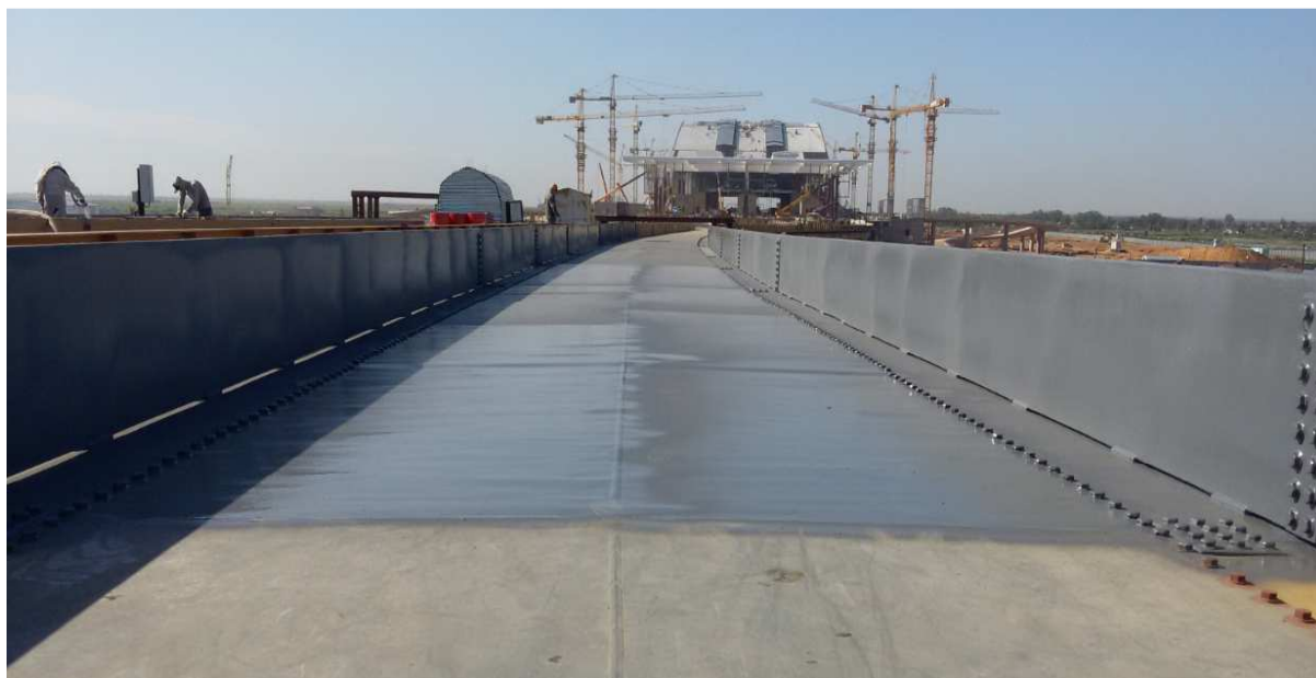
Рисунок 14 - Общий вид нанесенной гидроизоляции на металлическое основание
