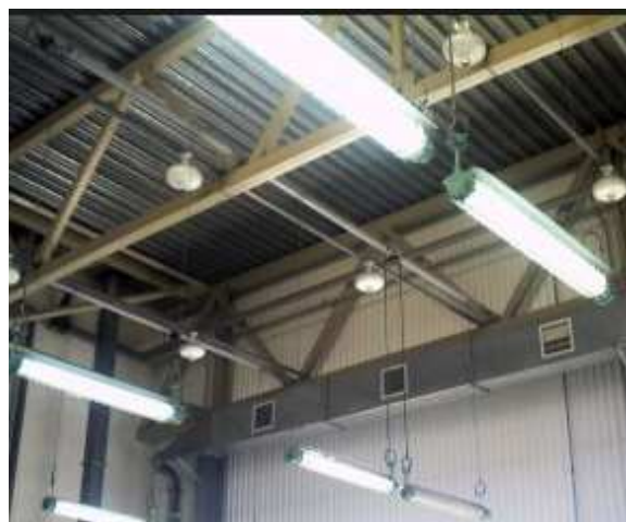
4-сурет - Ұнтақты өрт сөндіру қондырғысының сыртқы түрі
