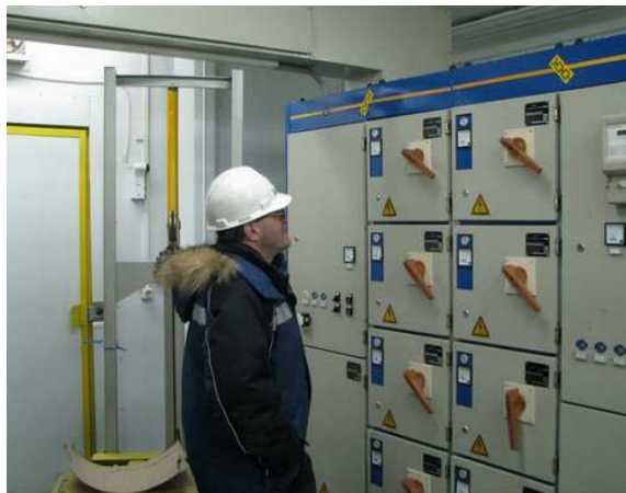
Рисунок 5 – Обслуживание автоматических установок порошкового пожаротушения (пусконаладочные работы)
