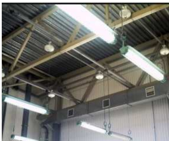
Рисунок 4 - Внешний вид установок порошкового пожаротушения
