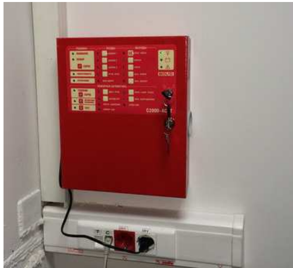
2-сурет - Ұнтақты өрт сөндіруге арналған автоматты қондырғыны басқарудың қабылдау-бақылау аспабы
