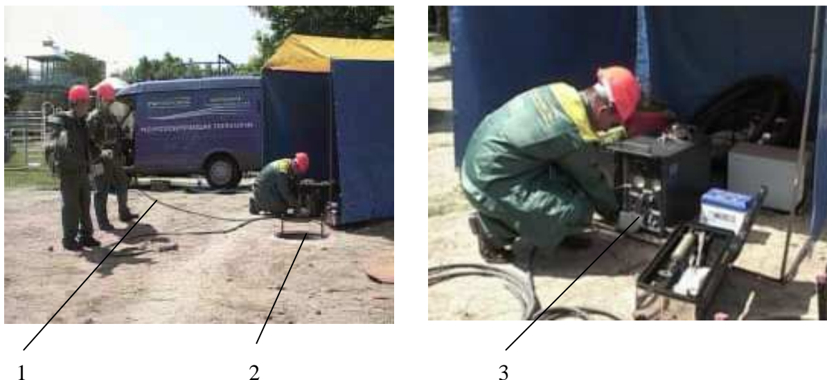
1 –КҚҚ-ММ-2 типіндегі қондырғының жұмыс шлангасы; 2 – телефон кәрізінің қақпағы; 3 – КҚҚ -ММ-2 типіндегі қондырғы
