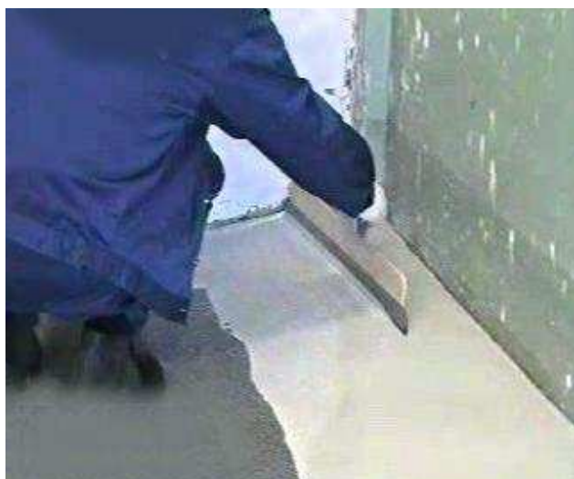
Рисунок 5 – Нанесение наливной композиции
