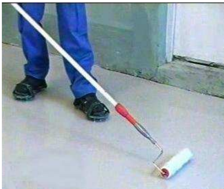
Рисунок 3 – Нанесение грунтовочной композиции с помощью малярного валика
