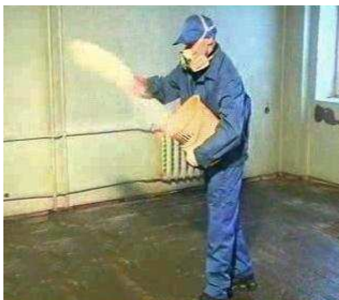
Рисунок 4 – Посыпка грунтовки песком
