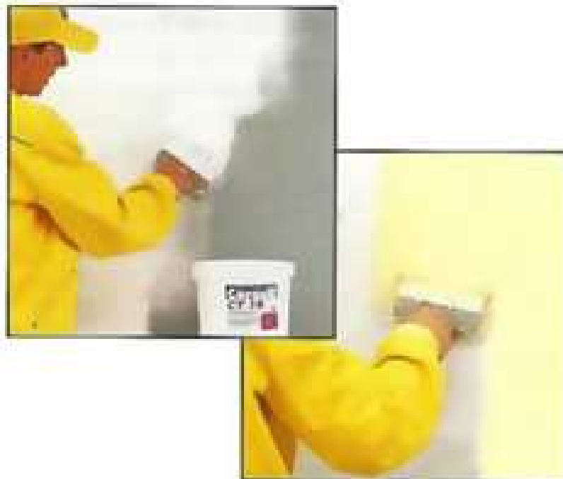
4-сурет - Қабырғаның үстінгі қабатына төсеме бояуды қылқаламмен жағу.
