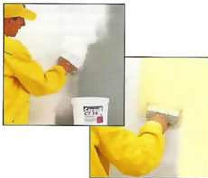
Рисунок 4 - Нанесение грунтовки на поверхность стены кистью.
