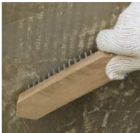
Рисунок 3 - Очистка поверхности основания стен при помощи щетки
