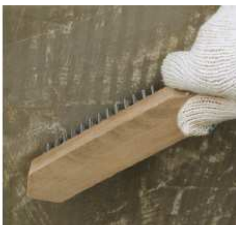
3-сурет - Қабырғалар негіздерін шөткенің көмегімен тазарту
