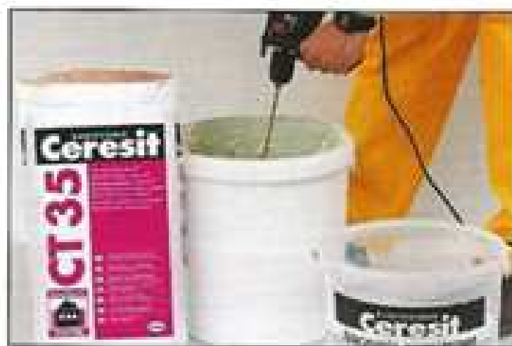
Рисунок 5 – Приготовление штукатурного состава
