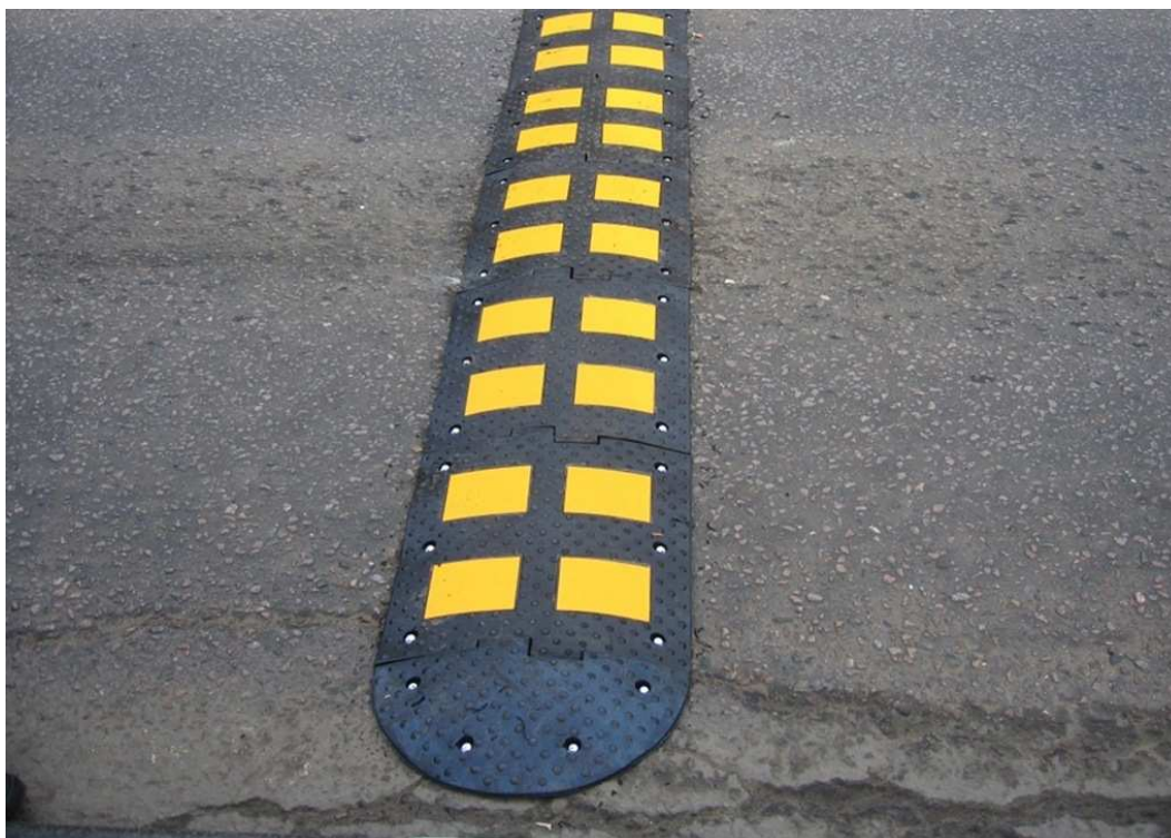
Рисунок 7 – Общий вид сборно-разборной конструкции искусственной дорожной неровности ИДН на дорожном покрытии
