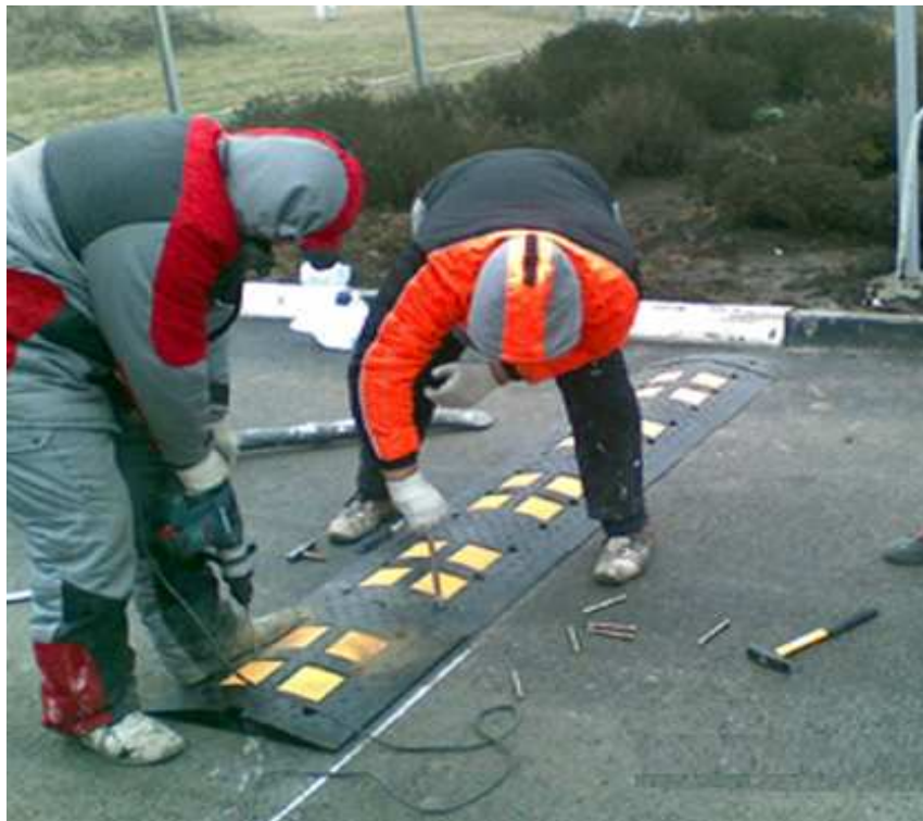
6-сурет - Жасанды жол бұдырлығының ЖЖБ жиналмалы конструкциясын монтаждау
