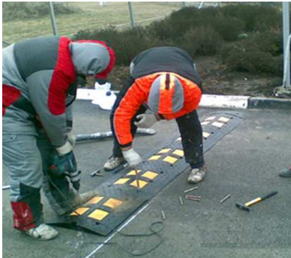
Рисунок 6 - Монтаж сборно-разборной конструкции искусственной дорожной неровности ИДН
